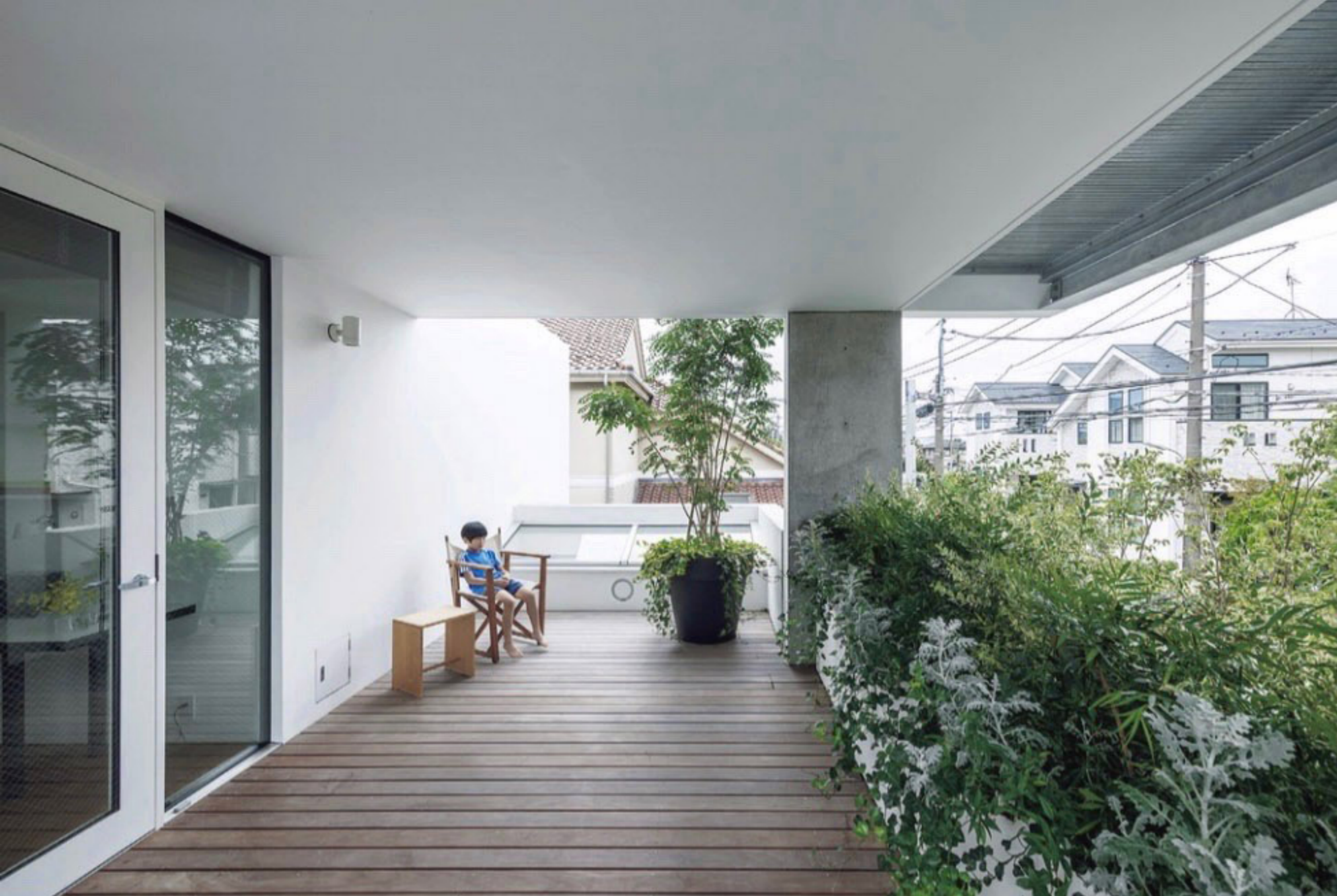
2階テラス。前面道路に向かって張り出す3階居間下の空間で、2階書斎を介して出入りする。天井高は2,500mm。植栽上部は26×50mmのスチールパイプを並べたデッキで、光と風を通す。
