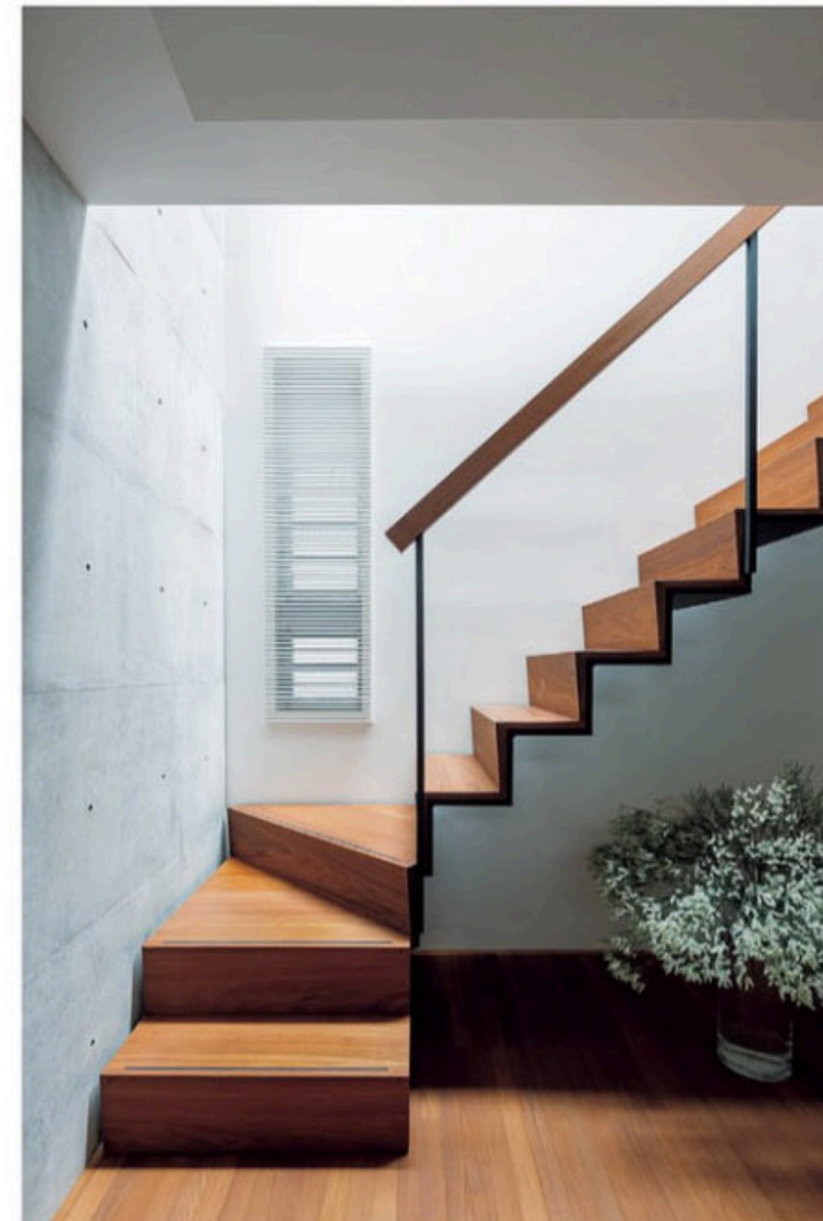
2階階段。蹴面は230mmをベースとしつつ、蹴上板を斜め加工することで15mmの蹴込みをつくり、昇降しやすさに配慮した。鉄骨下部の角にはゴムをつけて安全性も確保。窓はガラスルーバー窓とし木製ガラリの網戸もつけて、家全体に空気の淀みをつくらぬよう開口を設置している。
