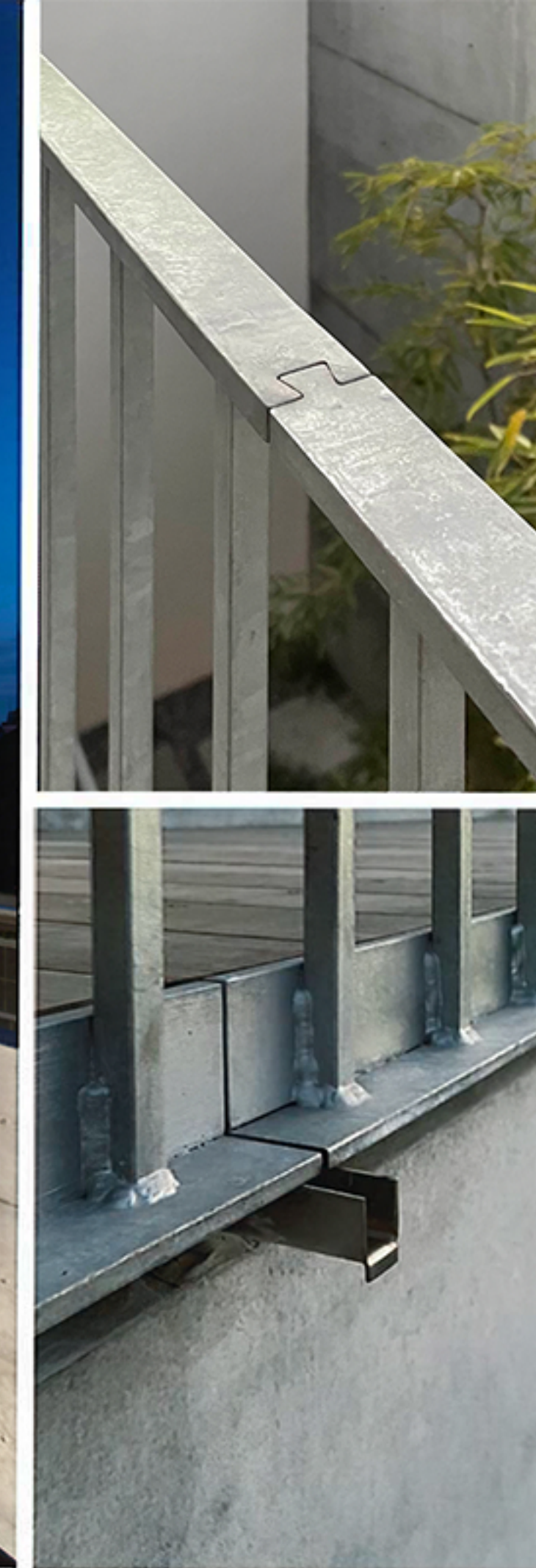
手摺 A 部 断面詳細 1 / 6 手摺ジョイント部 (上), ガーゴイル部 断面詳細 1 / 6 ガーゴイル立面 (下) 1 / 6 断面詳細 1 / 6
