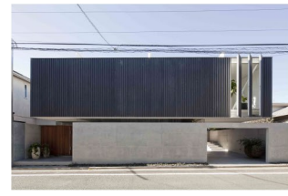
正面外観。道路側の建具を開けた状態
