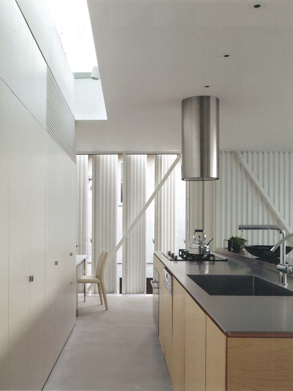
夫妻は会話や互いの気配を感じられることを大切に各室の計画を立てた。アムスタイルのオーダーキッチン(W3660mm×D900mm×H900mm)は食事や来客の際にも便利なアイランド型。カウンタートップは6mm厚のステンレスハイブレーション仕上げ。キッチン水栓はドイツ・GROHEの「Minta 3216800J」、レンジトップはリンナイの「RD312G11S」、レンジフードはイタリア・FABERの「CYLINDRA-ISOLA」。天井を460mm膨り込み、トップライト(W3785mm×H390mm)を設けて明るいキッチンに。奥には妻の作業用デスクを配した。正面はキーストーン鋼板の壁に電動制御で開閉する建具を設置。左手に当たる東側ファサードは開口がないため、2階の2カ所に電動建具を設置して通風を確保。建具を閉じると壁面と一体化するデザイン
