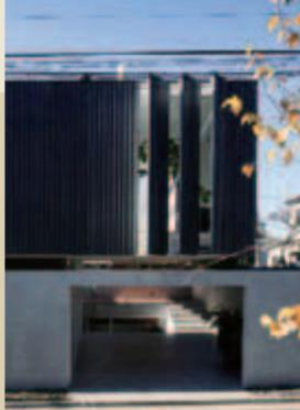
「PATIO」の2階外壁はキーストンプレート。一部が、通風のため電動で開閉する(写真5点=小川重雄)。
