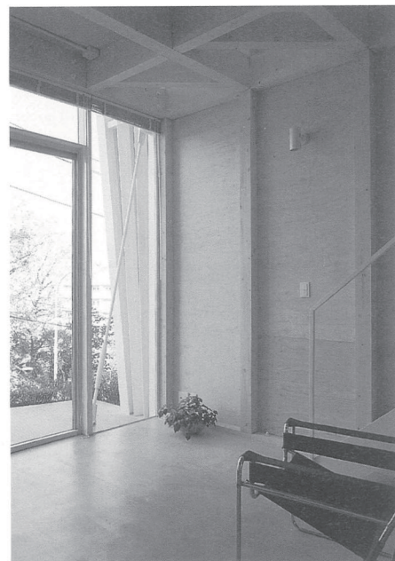
北西隅部を見る。サッシュ面を境に外部は鉄骨造で内部は木造
