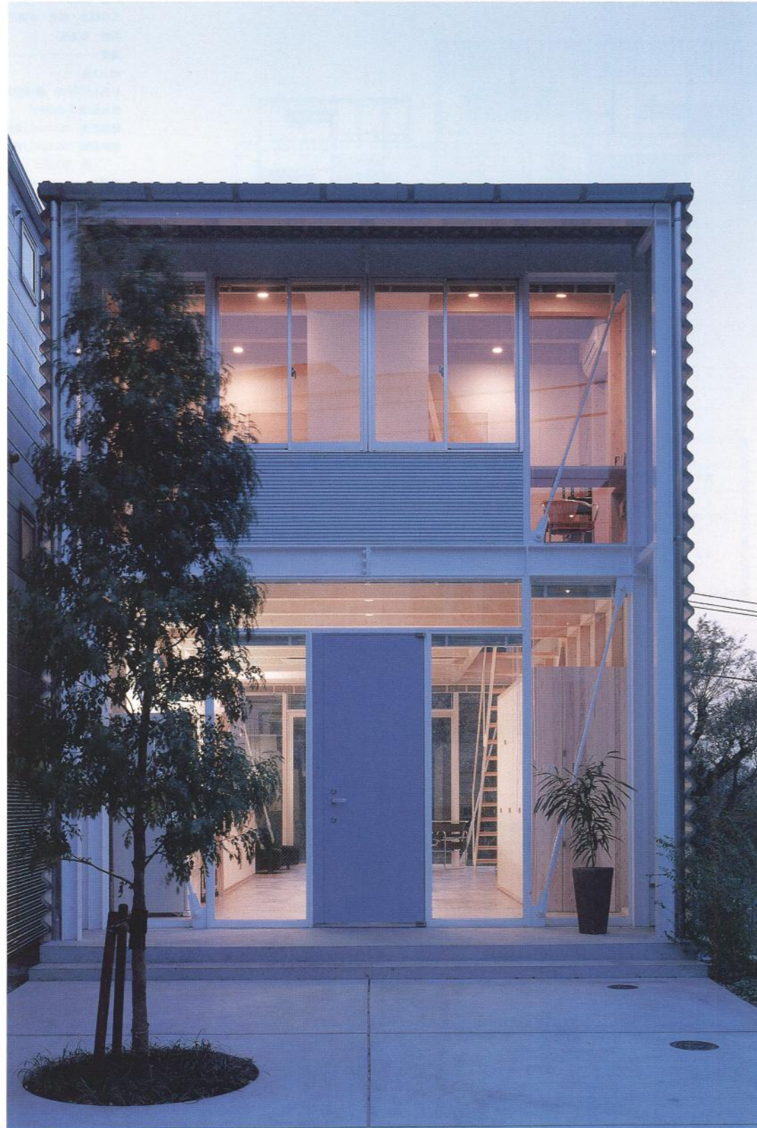
東側外観。内部空間を木造で、庇となる外部を鉄骨造とする異方向異種構造による、水平力は梁方向を鉄骨が桁方向を木材が負担している 上げ、写真手前側の鉄骨の柱は上端が屋内から屋外に向けて倒れている
