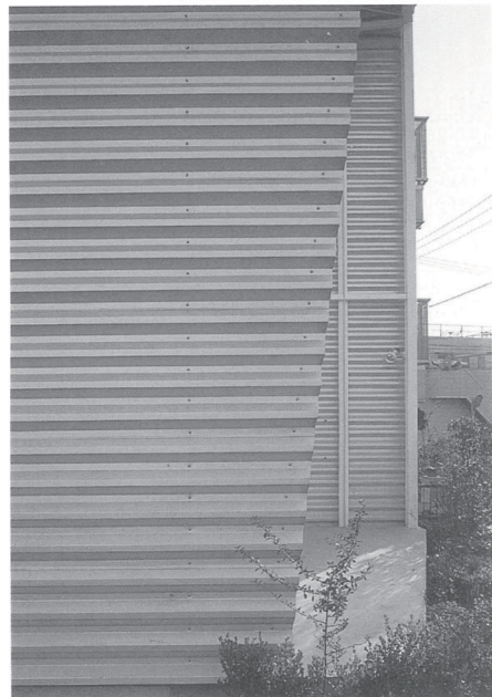
北西外部の足元を見る
