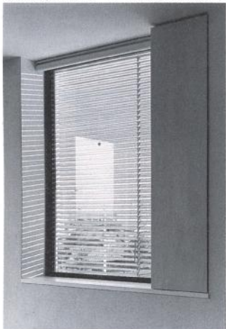
アルミ製のルーバー雨戸を見る
